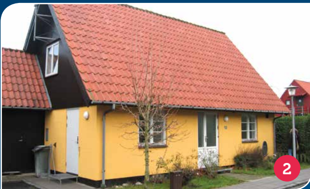
2. Dyrlæge Jürgensensgade 2-30 13 relativt store boliger opført i 1976. Beliggende i den nordlige del af Svaneke.
